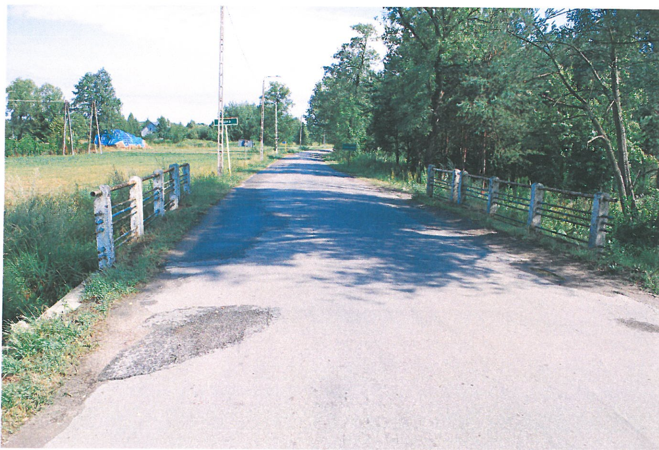
Widok ogólny mostu
