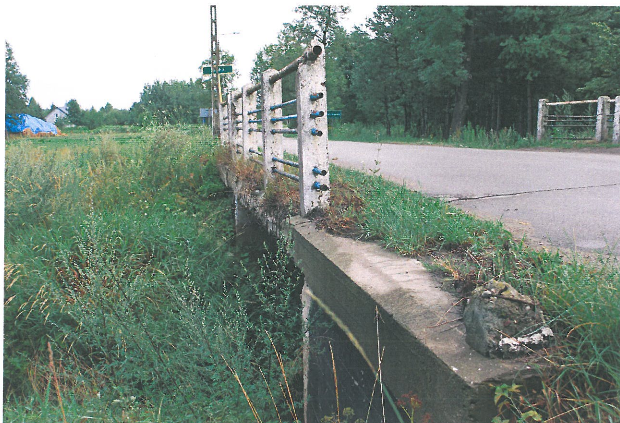
Fot. 3. Widok wzdłuż mostu od strony dolnej wody
