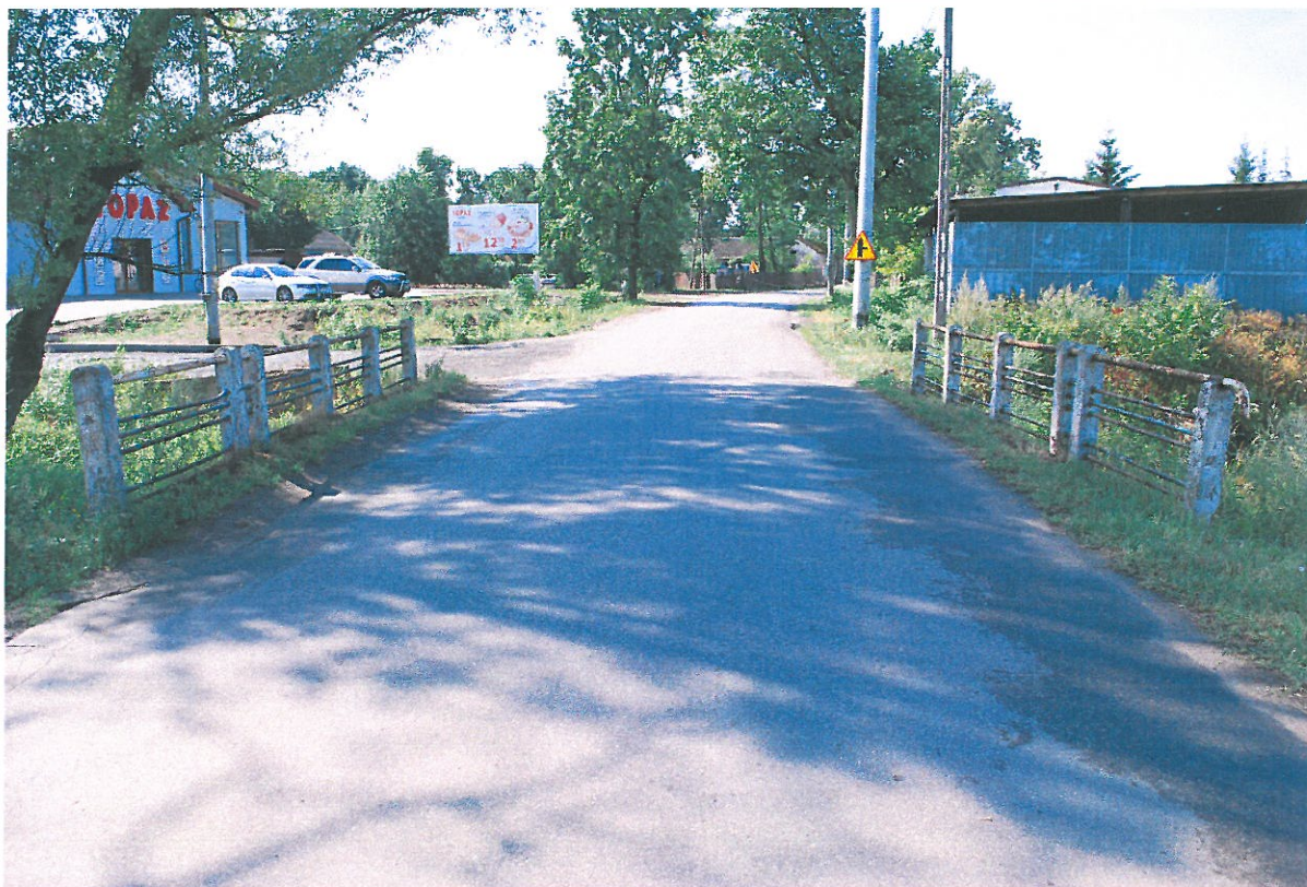
Fot. 1. Widok od strony północnej
